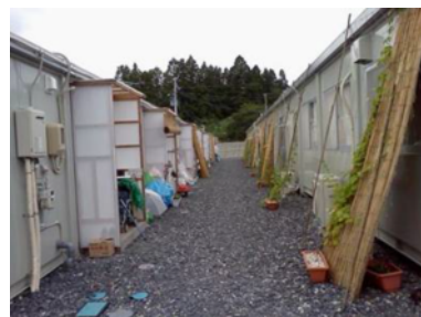
仮設住宅の様子
