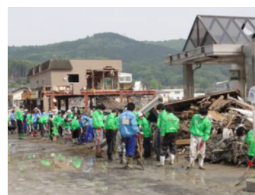
がれき撤去作業
