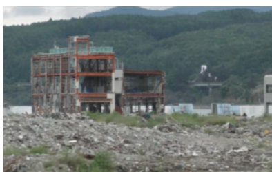
被災状況（南三陸町防災庁舎）
